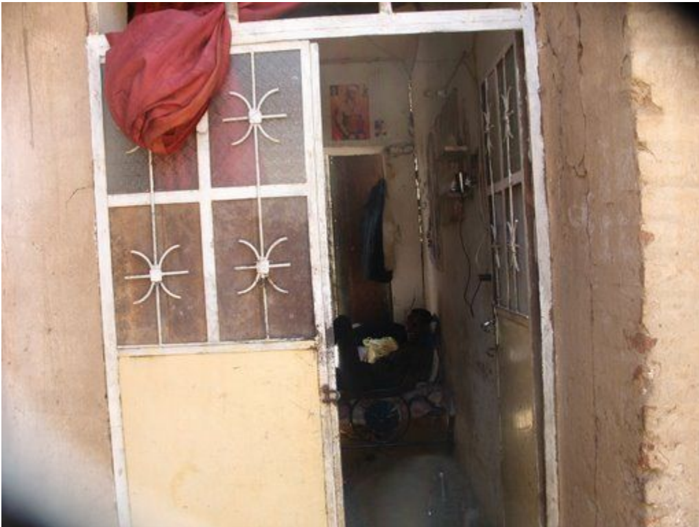
Inngangspartiet til en ettroms leilighet
