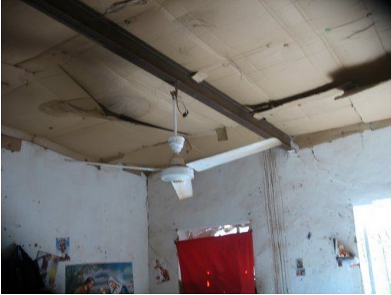
Taket er dekket med papp
